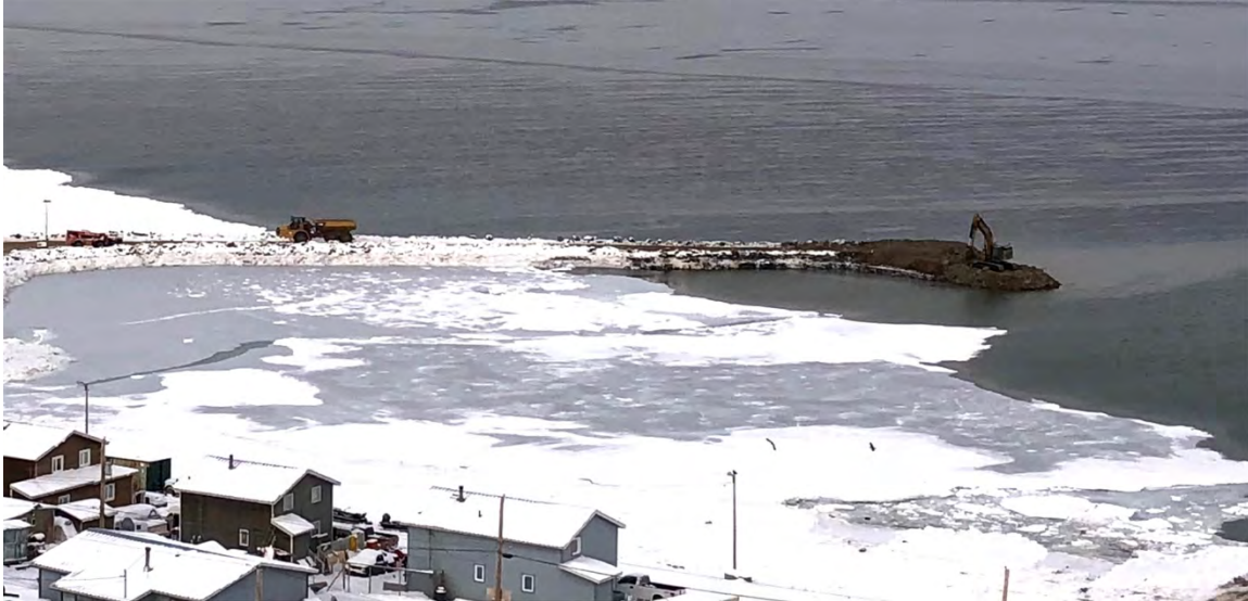
Début de la construction du brise-lame à Pond Inlet. Photographie gracieusement offert par Advisian
