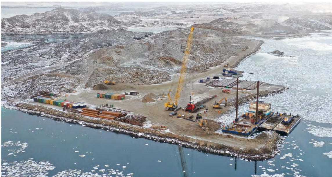
Avancement du nouveau quai en mer profonde et de la zone de dépôt à Iqaluit
