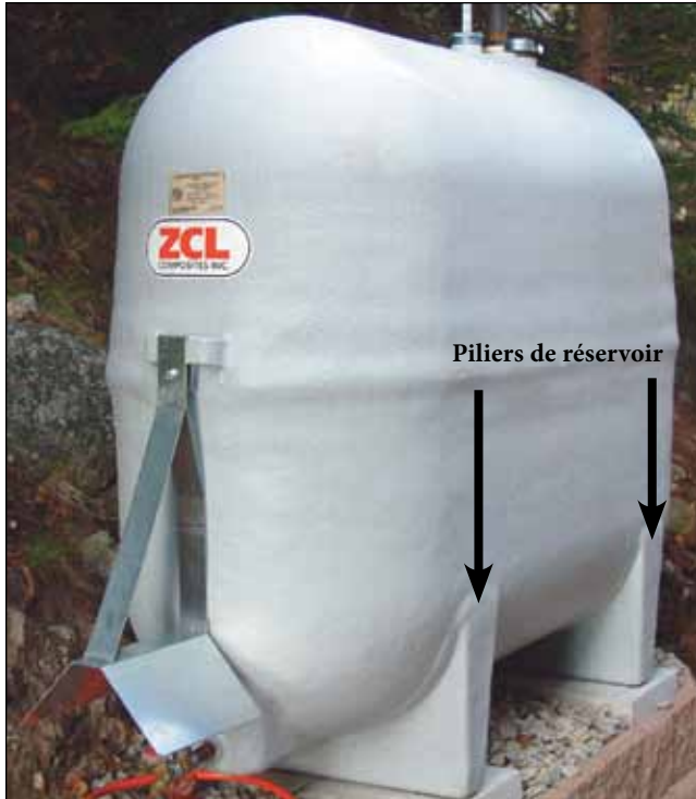
5.4 Réservoir à paroi simple en fibre de verre d'une capacité de 1 135 litres (250 gallons). Remarquez la paroi protectrice au-dessus de la soupape d'évacuation (photo offerte par la société ZCL Composites d'Edmonton, en Alberta).
