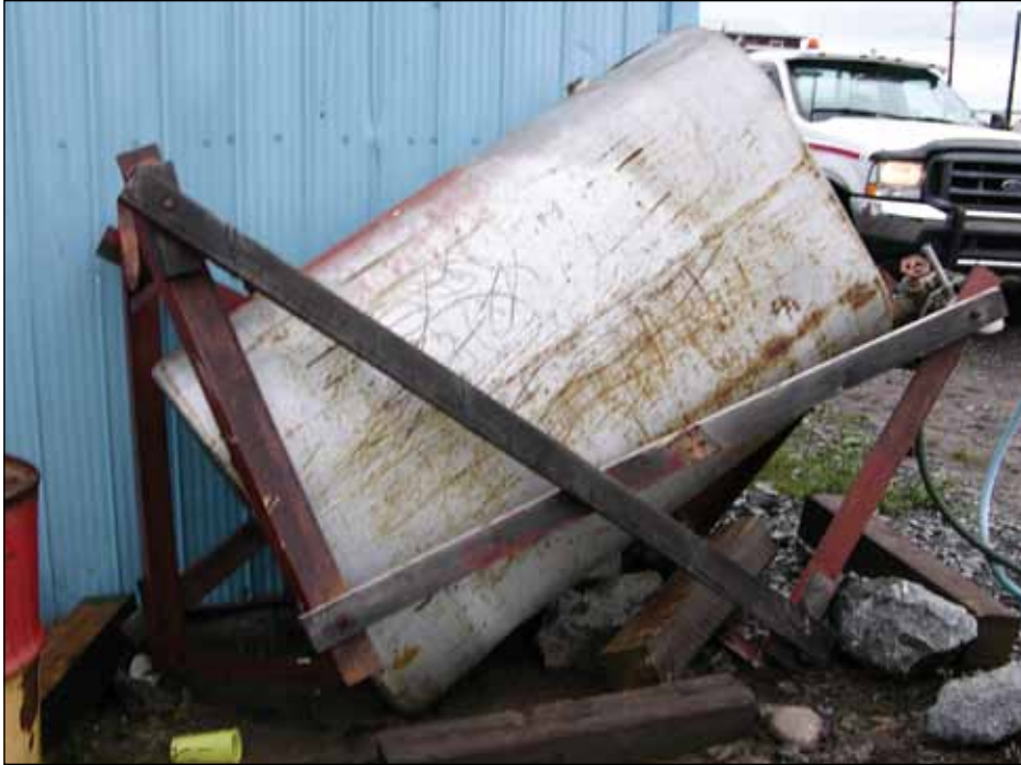
4.5b Ce réservoir d'huile de chauffage reposait sur un support de bois et métal qui a fini par s'effondrer sous le poids du réservoir, déversant 445 litres (100 gallons) d'huile de chauffage sur le sol.
