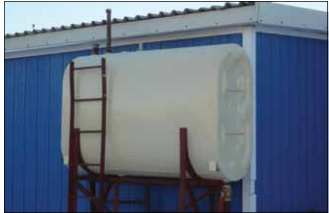
5.2 Réservoir d'huile de chauffage en acier à paroi simple et à double fond.
